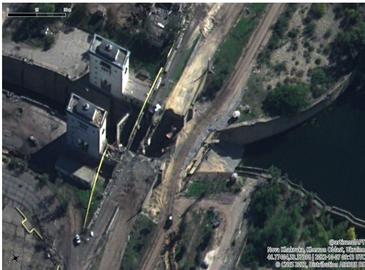
Figure 5. Четыре временных переезда через судоходный канал Каховской ГЭС, наведенные армией РФ после разрушения основного моста ракетными ударами. Источник: Warhappens
