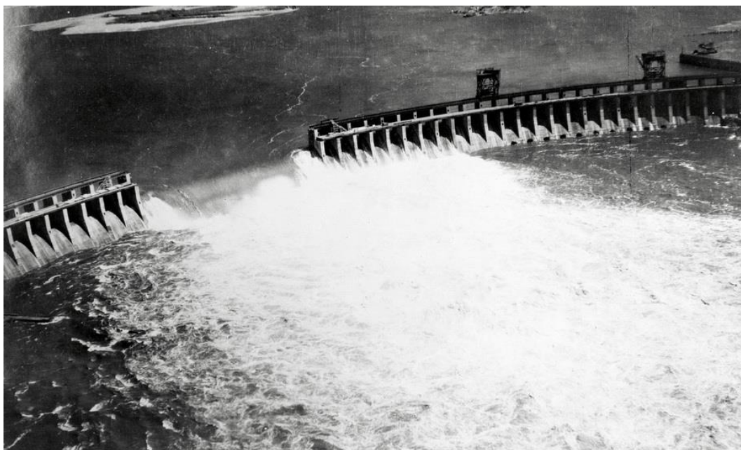
Figure 2. Проран в плотине Днепрогэс. Источник: Бессмертный барак
