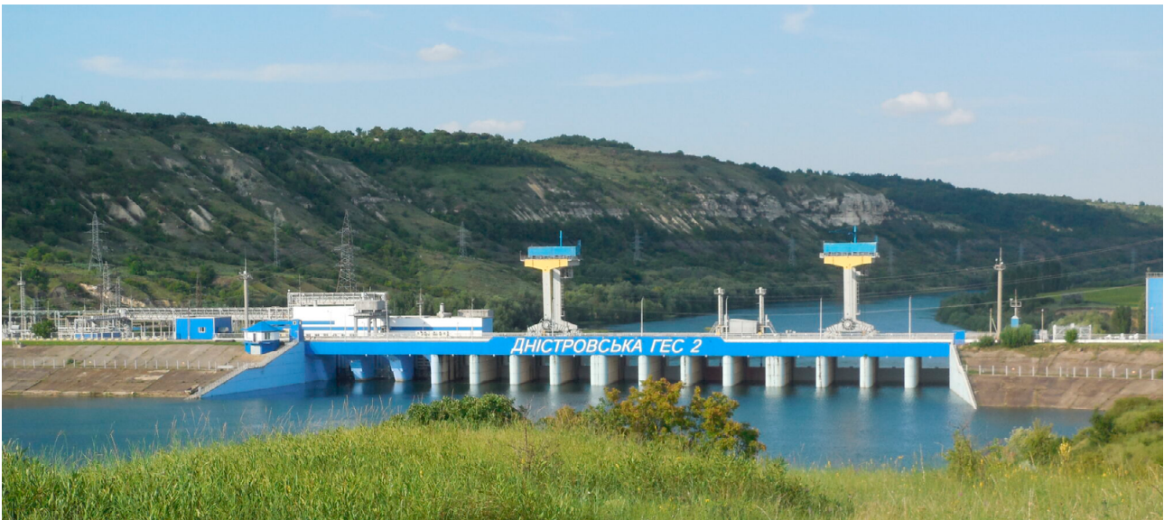
Фото 1. Днестровский гидроэнергокомплекс. ГЭС-2. Фото автора.
